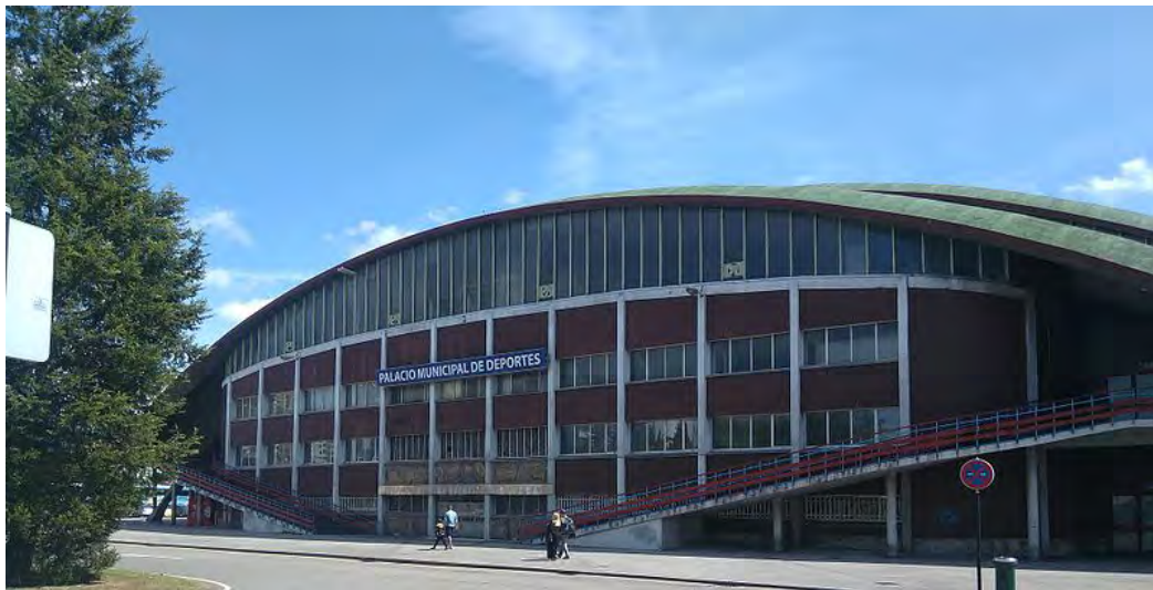
PALACIO DE LOS DEPORTES DE OVIEDO C/ Río Caudal, s/n - Oviedo, Asturias
